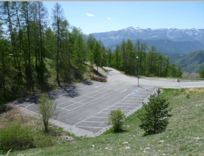
STATIONNEMENTS AMÉNAGÉS – VALBERG
