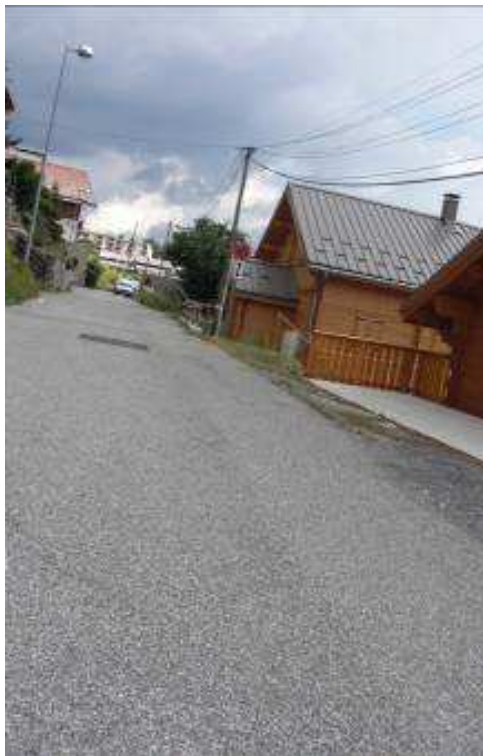
Photo RUE SAINT JEAN tronçon T4
