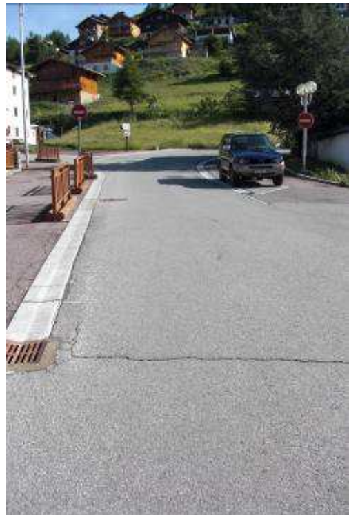
Photo RUE SAINT JEAN tronçon T2
