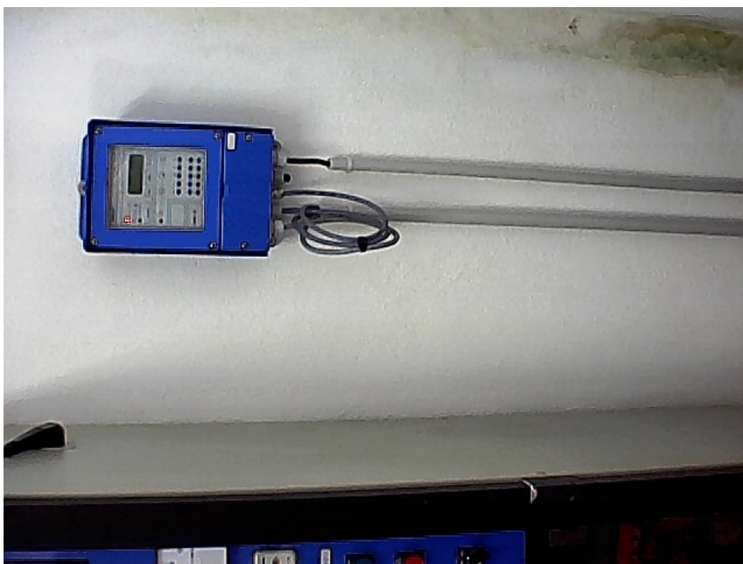
Débitmètre de la surverse. Caractéristiques : KRONE IFC 110 PF N° 13001
